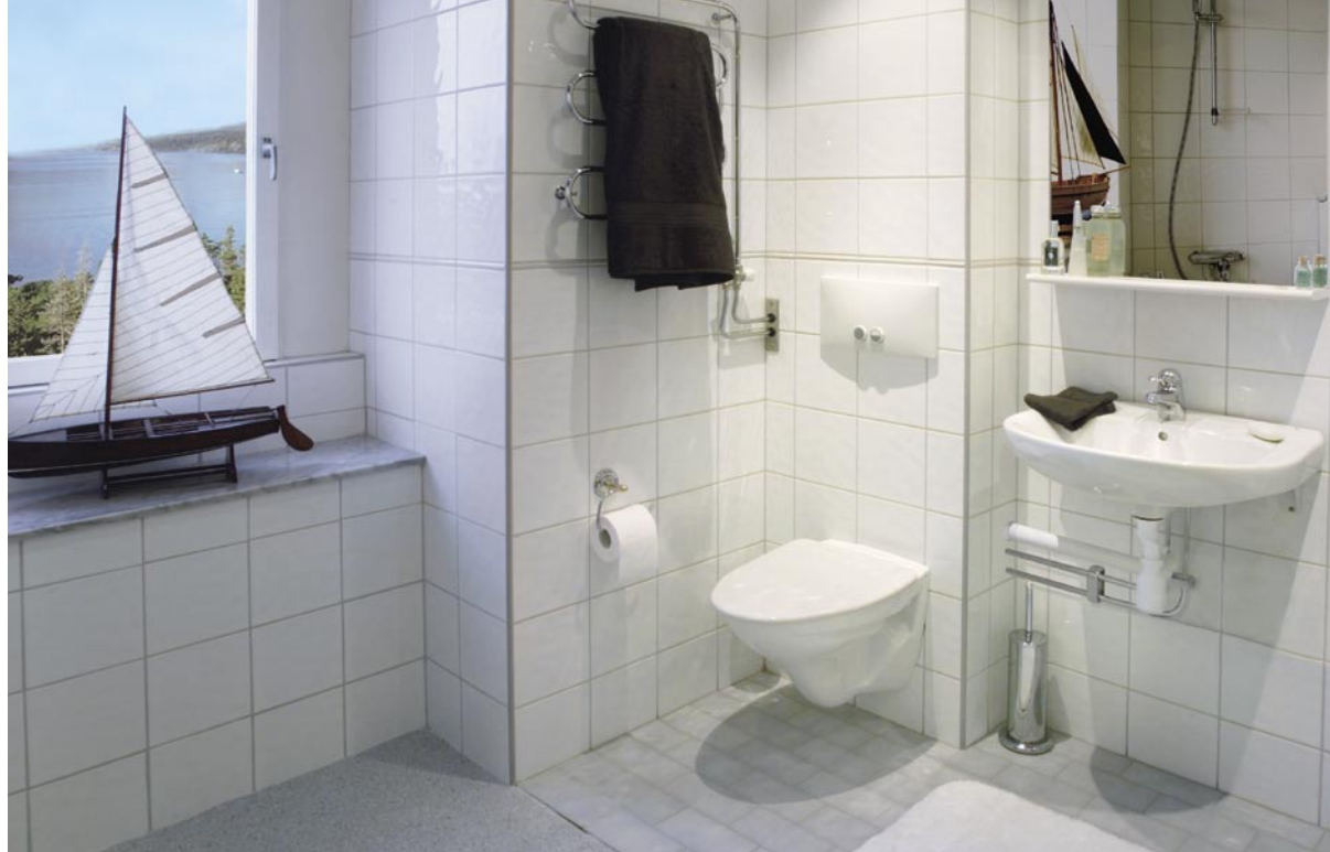
CombiKassett K60 med flis og sidetilkoblet servant
